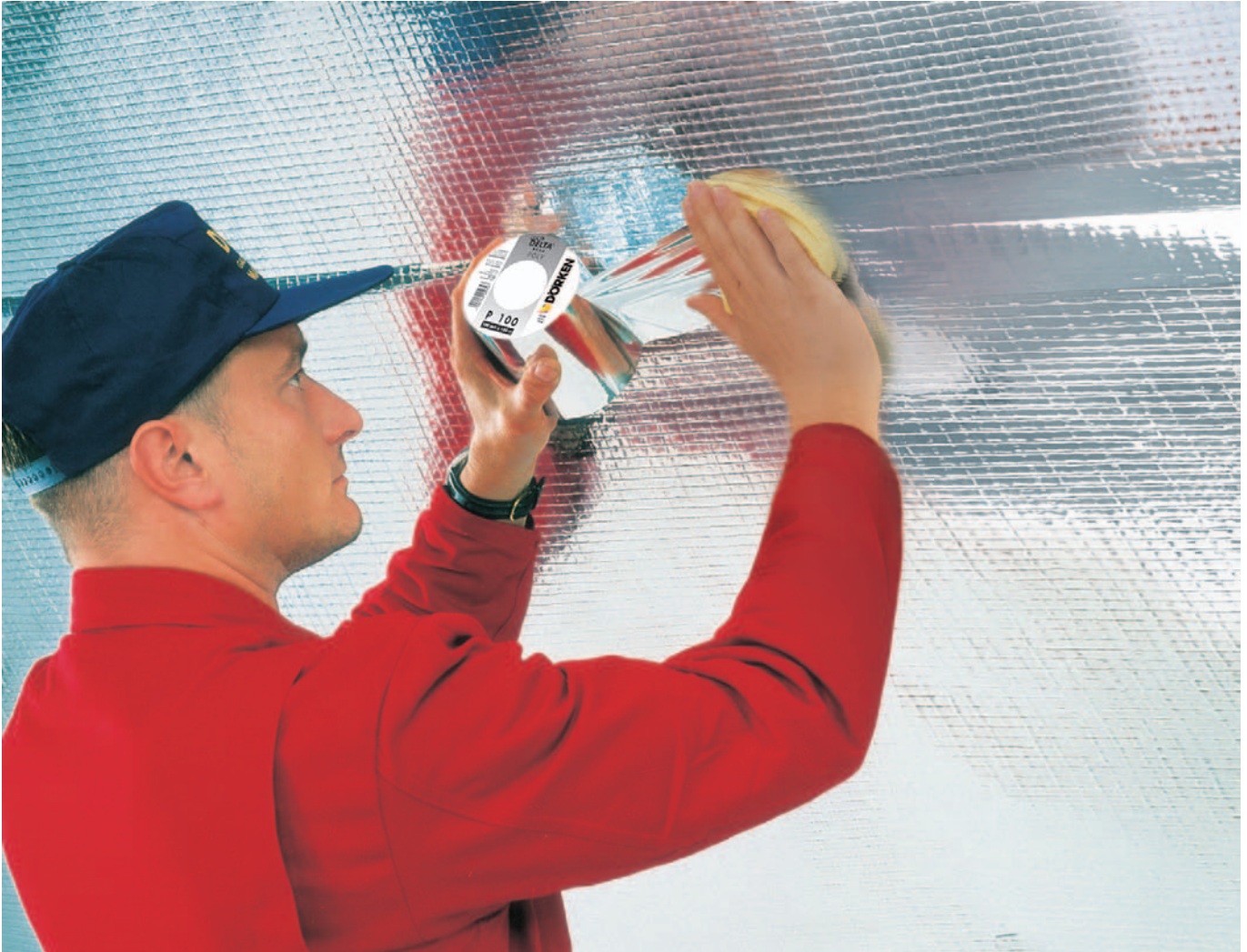
Mit DELTA®-Klebebändern können Luft- und Dampfsperren – hier DELTA®-REFLEX – leicht verarbeitet werden.
